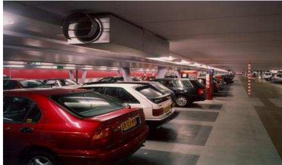
Figuro 2: Impulsventolilo. Tiu ĉi tipo konsistas kvazaŭ el mallonga aerdukto. Meze en ĝi troviĝas la ventolilo kiu suĉas aeron el la garaĝo per la orifiko de unu ekstremaĵo kaj blovas per la orifiko de la alia ekstremaĵo (videbla en la bildo). Fonto: firmao Novenco en retejo brandveilig.com.
