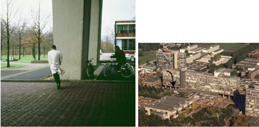
Figuro 1: Piediranto kliniĝas pro forta vento en pasejo sub granda konstruaĵo sur la tereno de la Tehnologia Universitato de Eindhoven (NL). La dekstra foto montras per sago la pozicion de la pasejo. La konstruaĵo altas je 45 m.
